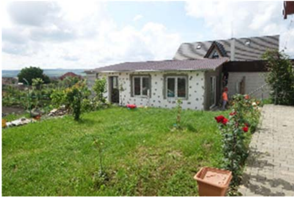
Der Rohbau für die neue Küche
